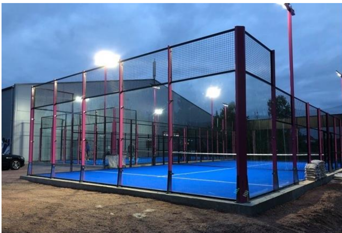
Padelbane nr.2 – ferdigstilt slutten av august 2021
