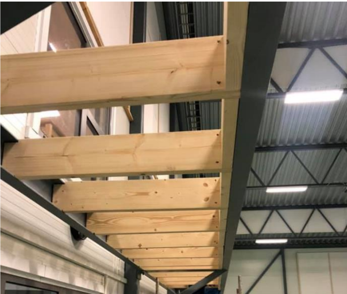
Espen og Tommy er i gang med støtte konstruksjonen for plattingen
