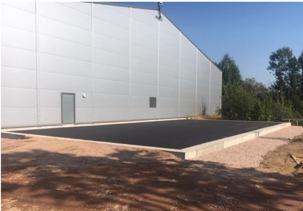
Platen ferdig støpt og asfaltert
