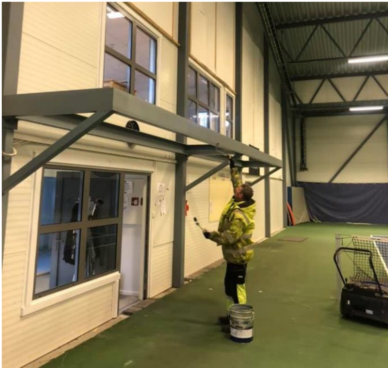
Siste finish fra konstruksjonsarbeiderne
