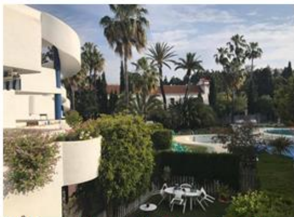
Utsikt fra en av leilighetene på Ona Campanario med den norske sjømannskirken like bak bassenget.
